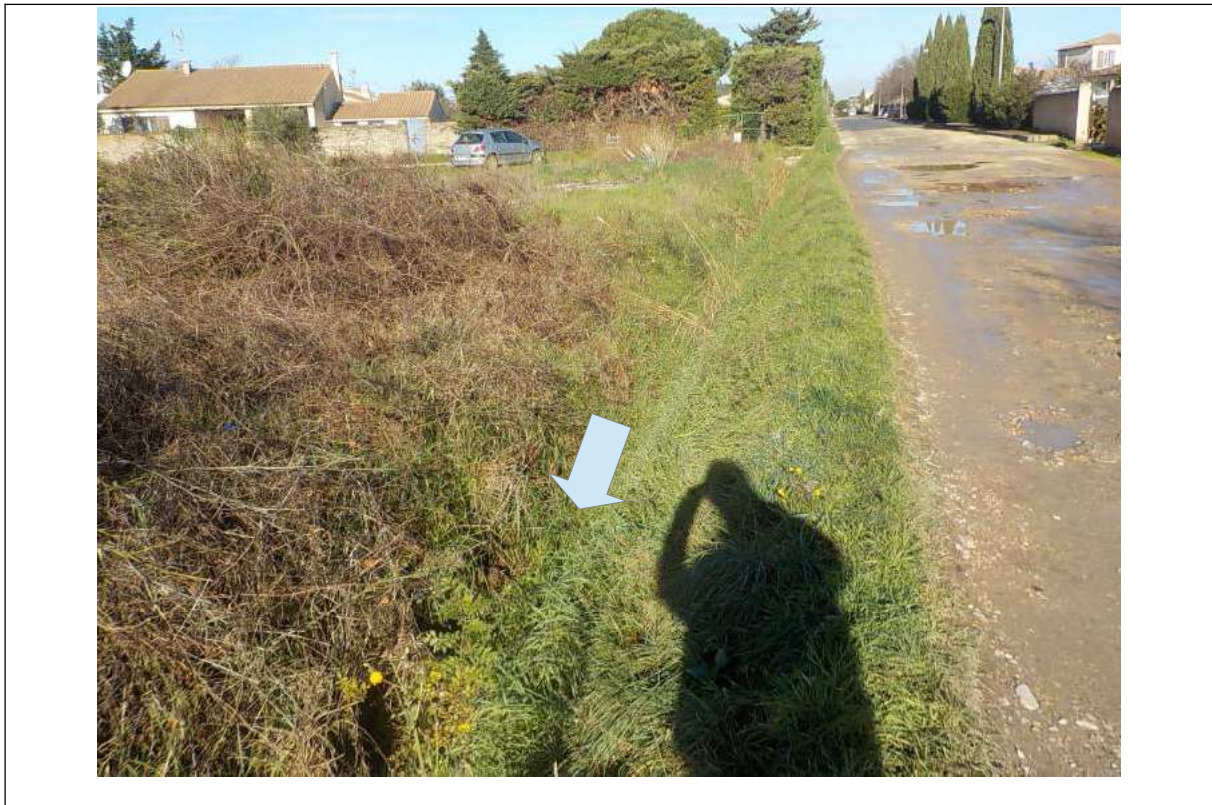
Photo 3 : Avenue de Camargue et fossé pluvial exutoire (vers l'amont)
