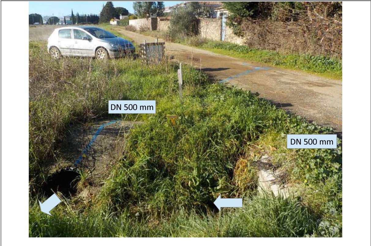
Photo 2 : Tracé du réseau existant sous la voirie et rejet existant au fossé pluvial communal
