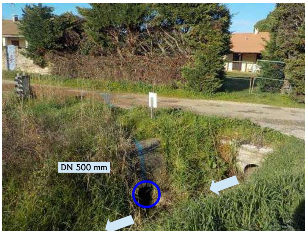
Arrivée du DN 500 mm après le départ du fossé
