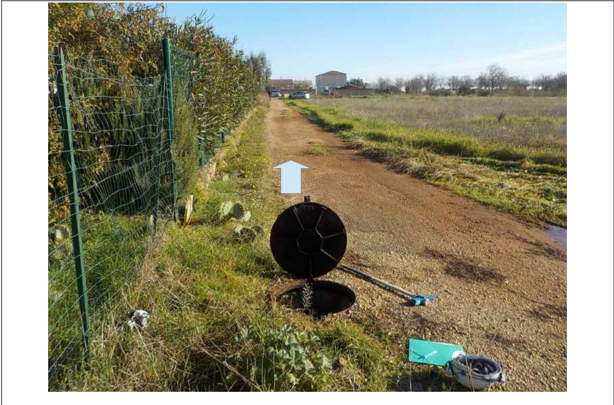
Photo 1 : Début du réseau pluvial existant sous la voirie (rejet de l'opération amont vers le fossé)
