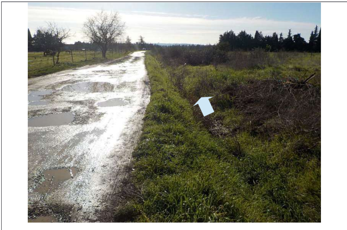
Photo 4 : Avenue de Camargue et fossé pluvial exutoire (vers l'aval)
